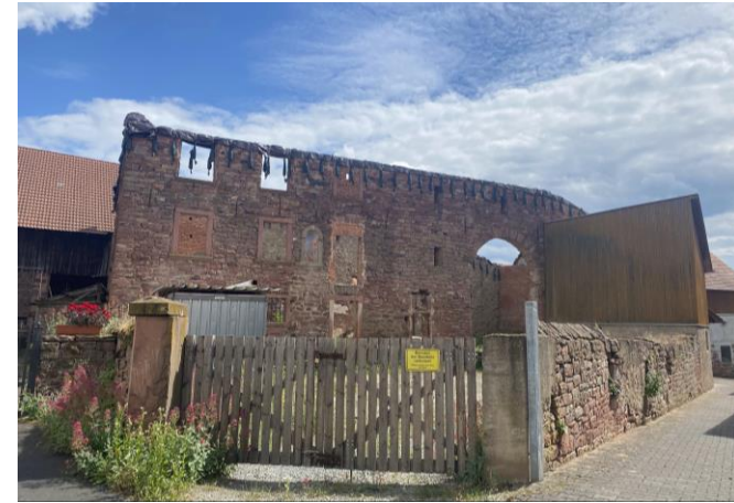
Abbildung 27: Baustelle in Röllbach
